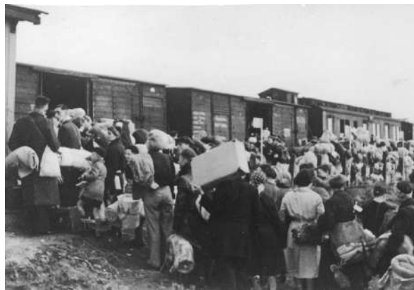
Eén van de ruim 100 transporten Vanuit kamp Westerbork
